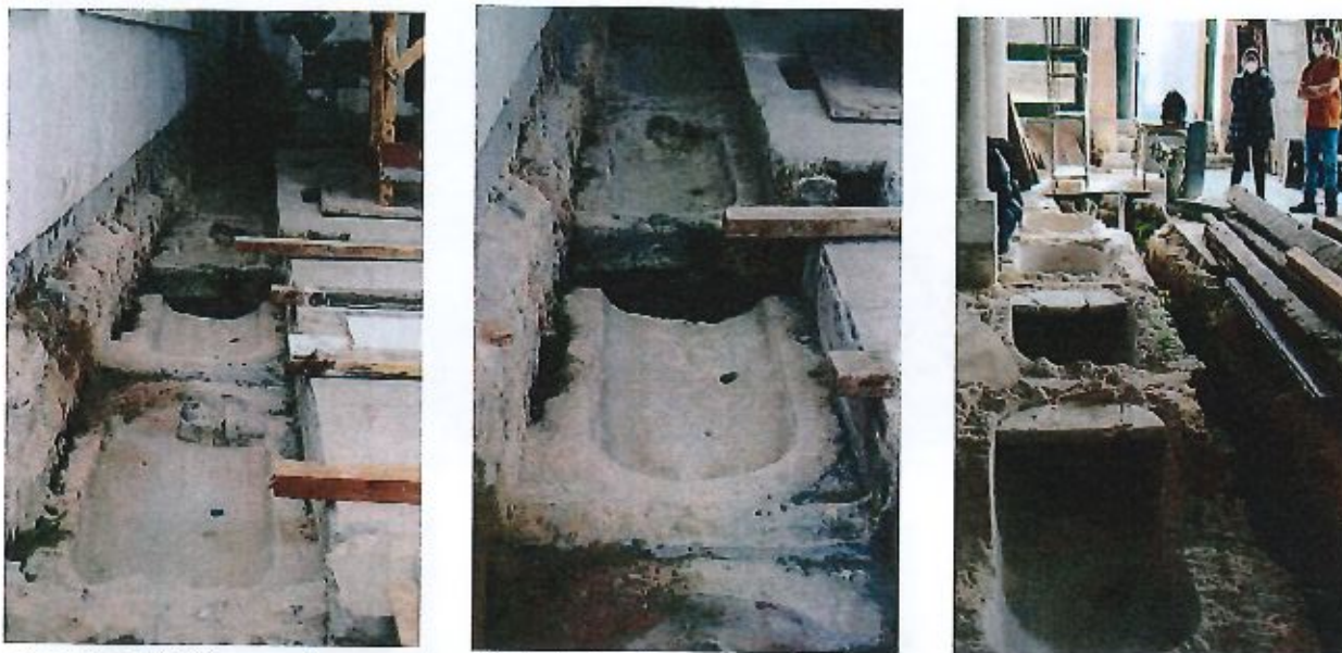
Figs. 50 a 52. Vista para diversas ordens de banheiras das antigas Alcaçarias do Duque. PM, 4.11.2021.
