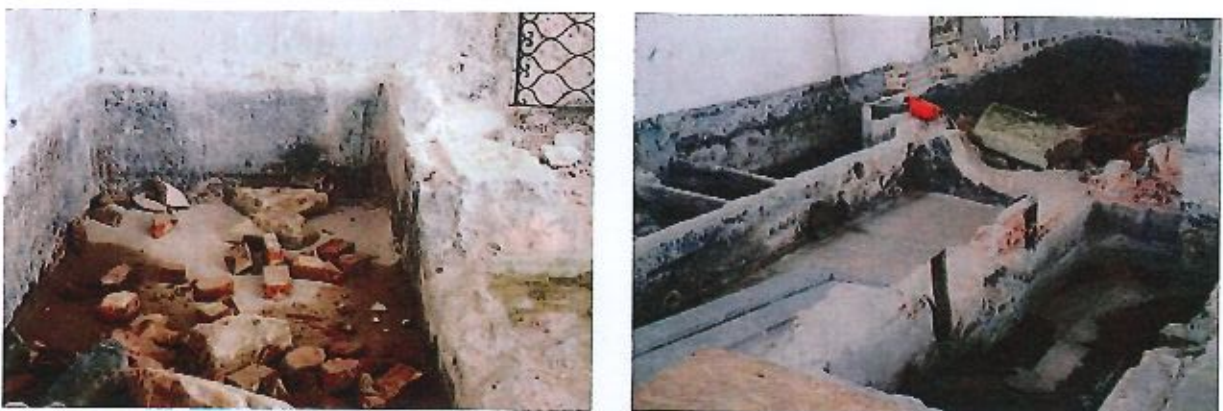
Figs. 41-42. Pormenor dos tanques/reservatórios. PM, 4.11.2021.
