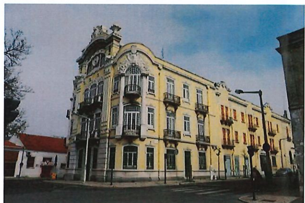
Fig. 10. O edifício sede, fachada principal à Praça David Leandro da Silva, e vista parcial da fachada lateral à Rua Fernando Palha.
