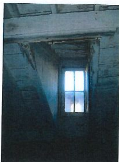
60. Interior de uma das divisões do sótão, com acesso ao vão de janela (05.11.2014).
