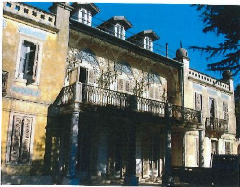
12. Corpo central da fachada principal (05.11.2014).
