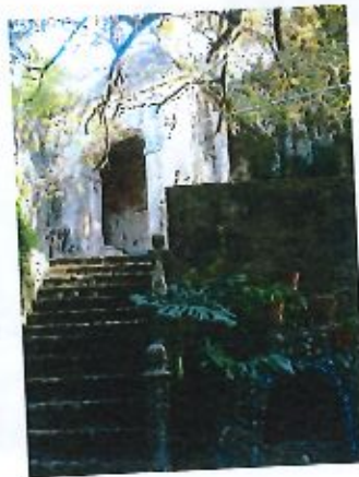
41. Fonte e escadaria de acesso à casa de fresco (05.11.2014).
