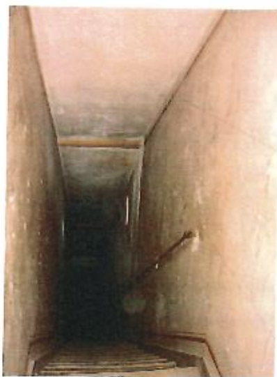
59. Escada de acesso ao sótão (05.11.2014).
