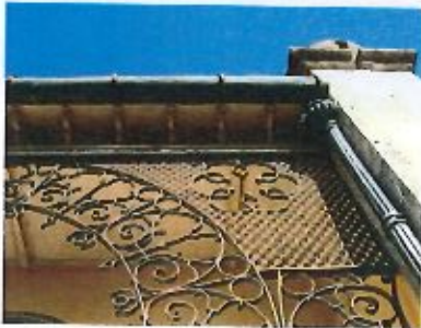
24. Vista parcial do trabalho dos elementos decorativos em ferro na varanda (05.11.2014).
