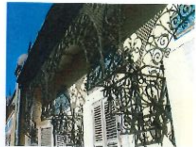
23. Vista parcial do trabalho dos elementos decorativos em ferro na varanda (05.11.2014).
