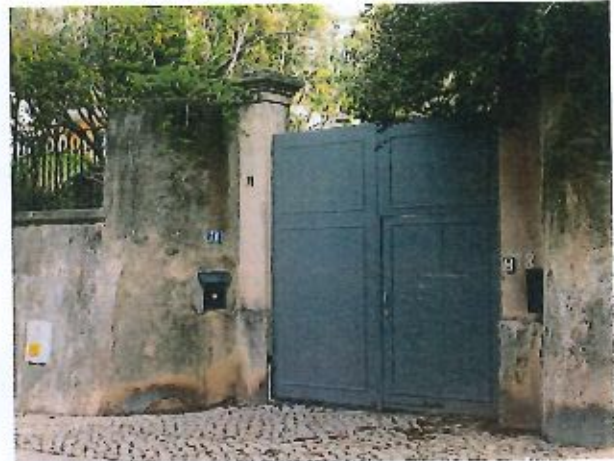
11. Muro e portão de entrada. O portão original em ferro foi substituído por um "vulgar" portão em chapa de ferro (15.12.2016).
