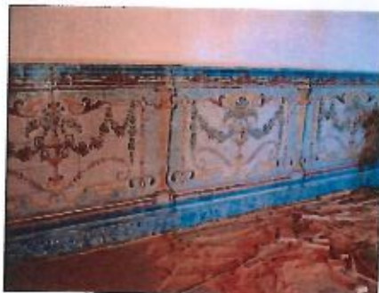
74. Lambrim de azulejos do salão do primeiro piso (05.11.2014).
