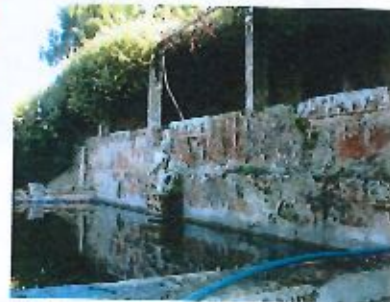
48. Vista do tanque de irrigação para rega e refresco existente na quinta (05.11.2014).
