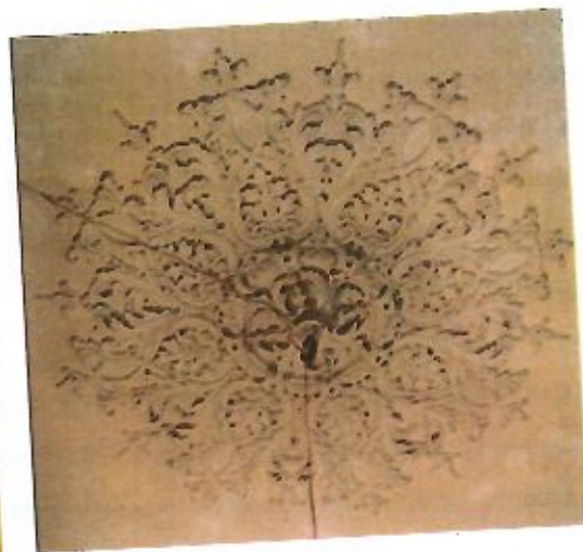
78. Detalhe do florão central em estuque (05.11.2014).
