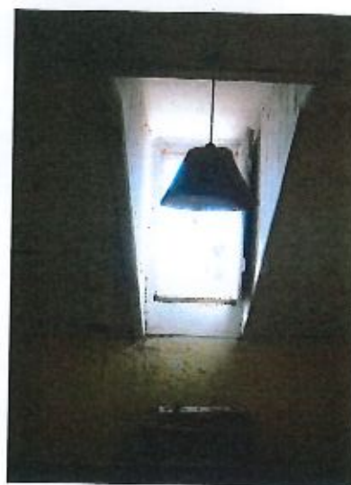
61. Interior de uma das divisões do sótão, com acesso ao vão de janela (05.11.2014).
