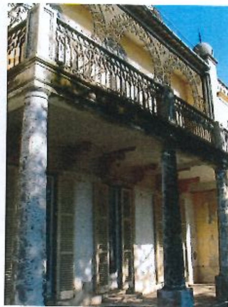
13. Vista da varanda, piso térreo e colunas (05.11.2014).
