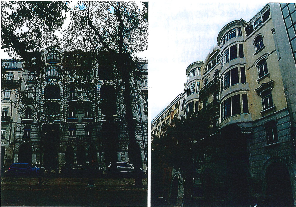
FIGURAS 1 e 2 – Vistas das fachadas para a Avenida da Liberdade e Rua Rodrigues Sampaio
