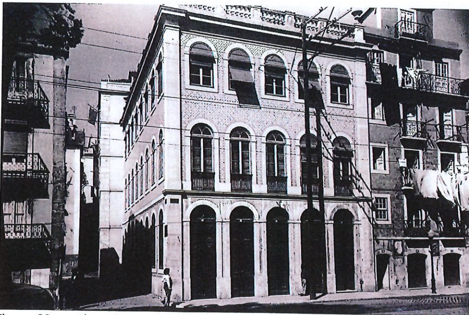
Fig. 20. Alcaçarias do Duque, 1951. Fotografia de Eduardo Portugal (1900-1958), PT/AMLSB/CMLSBAH/PCSP/004/EDP/001123. In http://arquivomunicipal.cm-lisboa.pt/pt/contactos/arquivo-fotografico/ .
