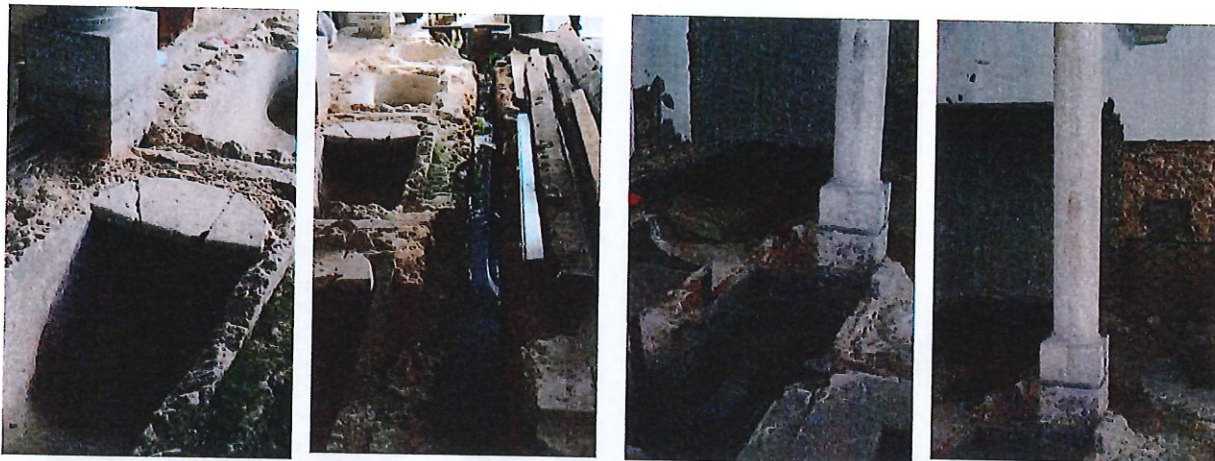
Figs. 27-28-29-30. Pormenor das banheiras. PM, 4.11.2021.
