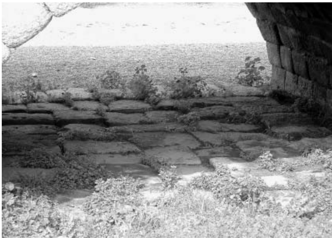
Fig. 17 Detalle de la caja de relleno con bloques de granito del arco cuarenta y cuatro.
