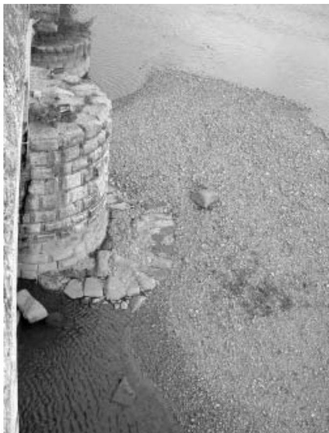
Fig. 14 Huellas de una pilastra con tajamar adelantado. Puente sobre el Guadiana.
