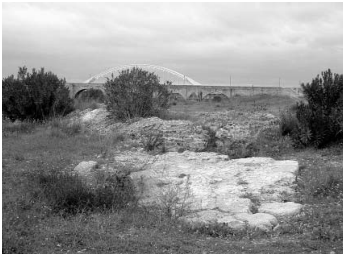
Fig. 11 Restos de la proa del tajamar del puente romano de Mérida.
