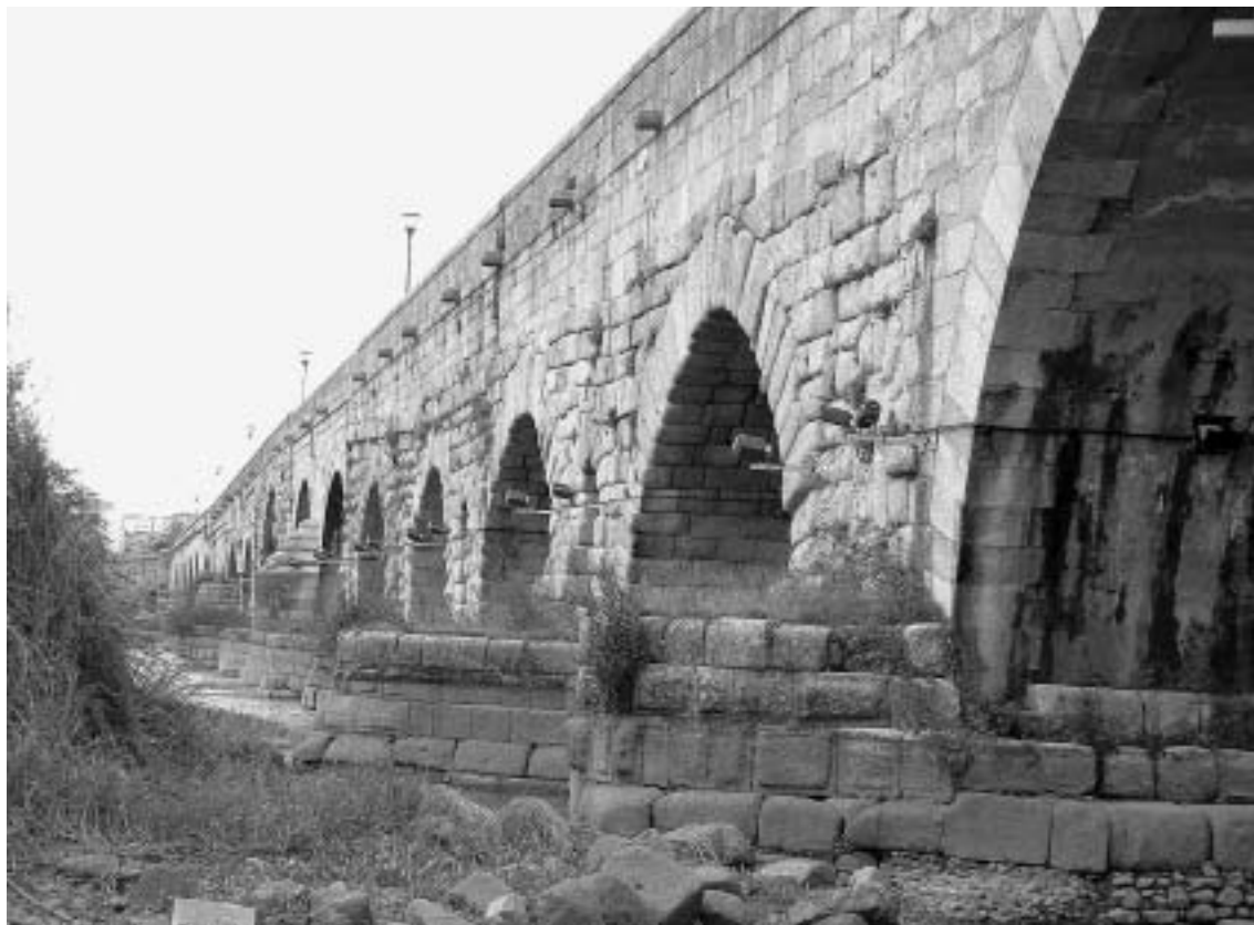
Fig. 6 Arcos retocados del puente central (19,18 y 17) y pilas adelantadas.
