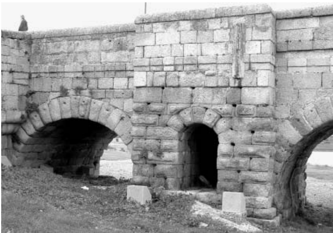
Fig. 13 Torre rectangular con arquillo de aligeramiento del puente romano de Mérida.
