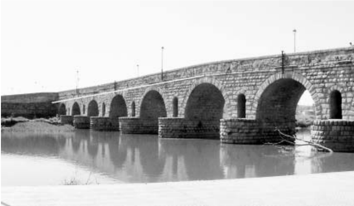
Fig. 8 Puente romano de Mérida. Arcos del segundo puente.
