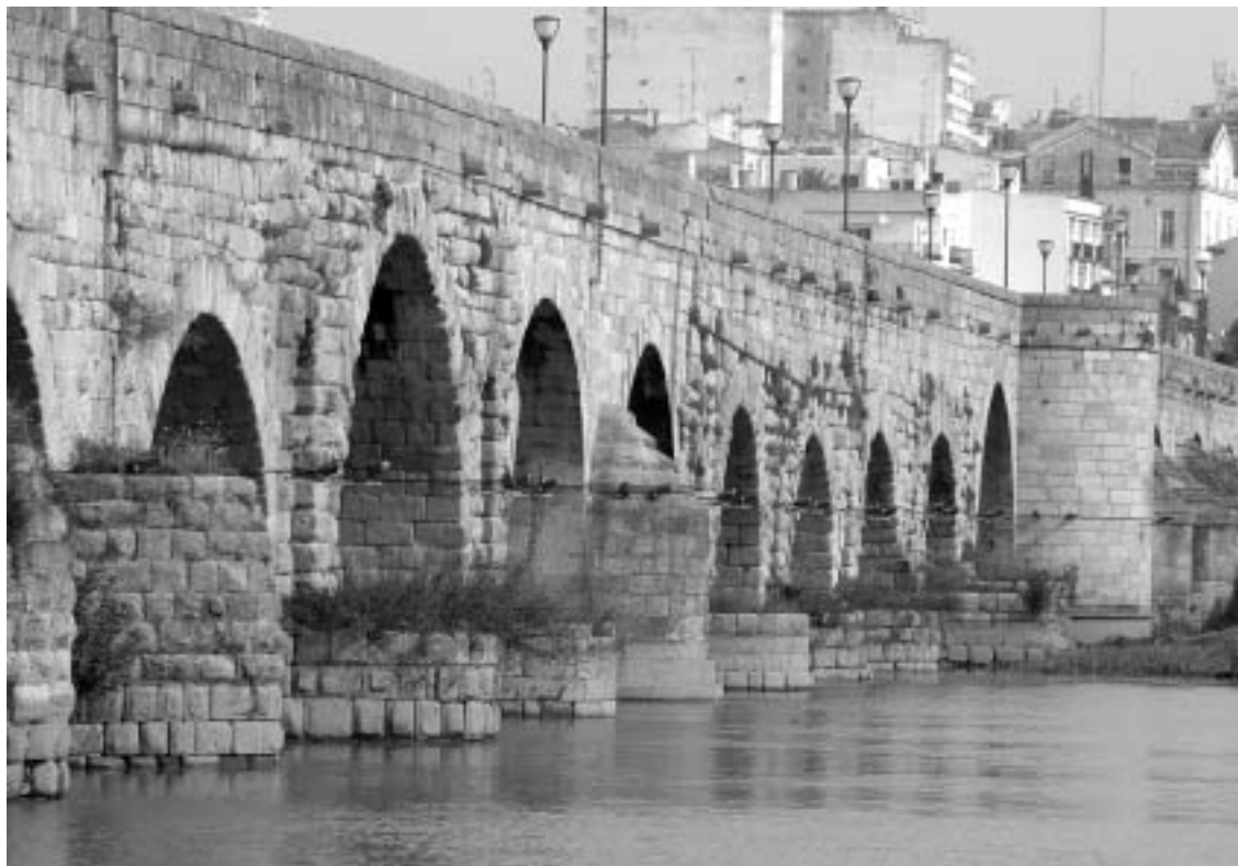
Fig. 4 Puente sobre el Guadiana. Parte central.
