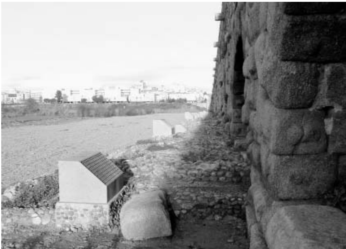
Fig. 18 Refuerzo de hormigón romano para fortalecer la obra durante el desembalse rápido.
