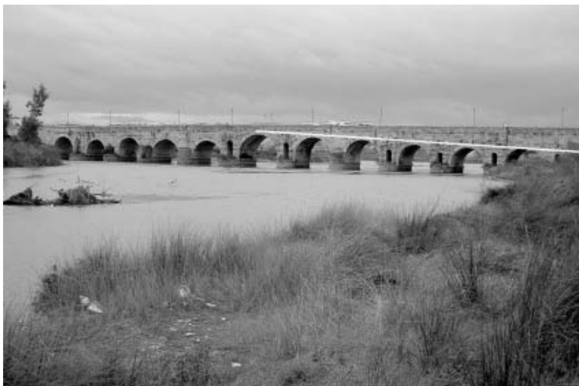
Fig. 5 Vista general del puente sobre el Guadiana. Puente n.º 1.
