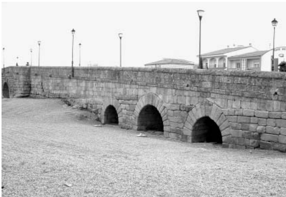
Fig. 19 Arcos del final del puente romano.
