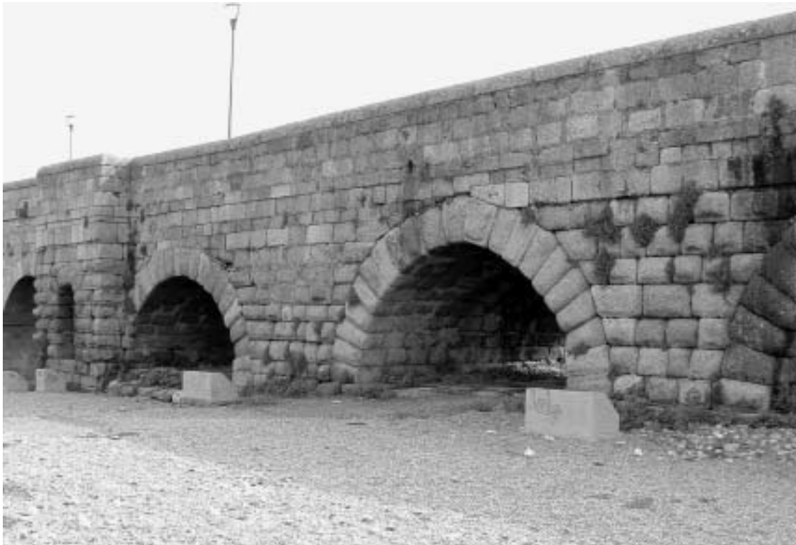
Fig. 15 Arcos y pilastras sin arquillos de aligeramiento. Tramo de unión del primer y tercer puente.
