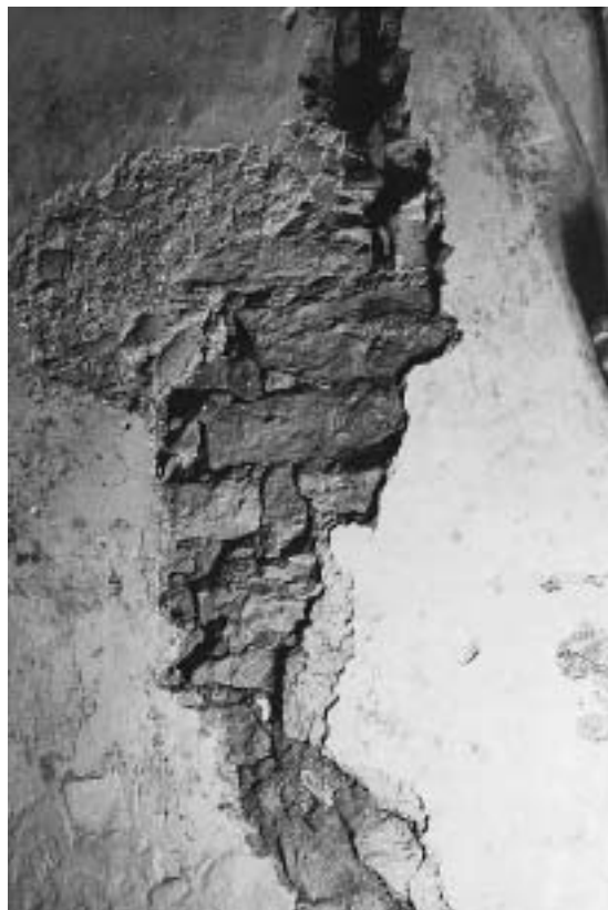
Fig. 15 Ermida do Espírito Santo: pormenor das fissuras de grandes dimensões.
