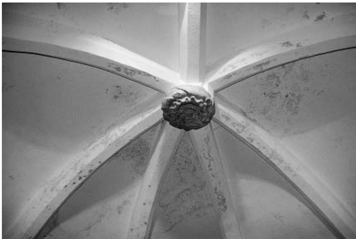
Fig. 18 Ermida do Espírito Santo: pormenor das nervuras junto da peça de fecho — florão — no tecto após a intervenção de restauro.
