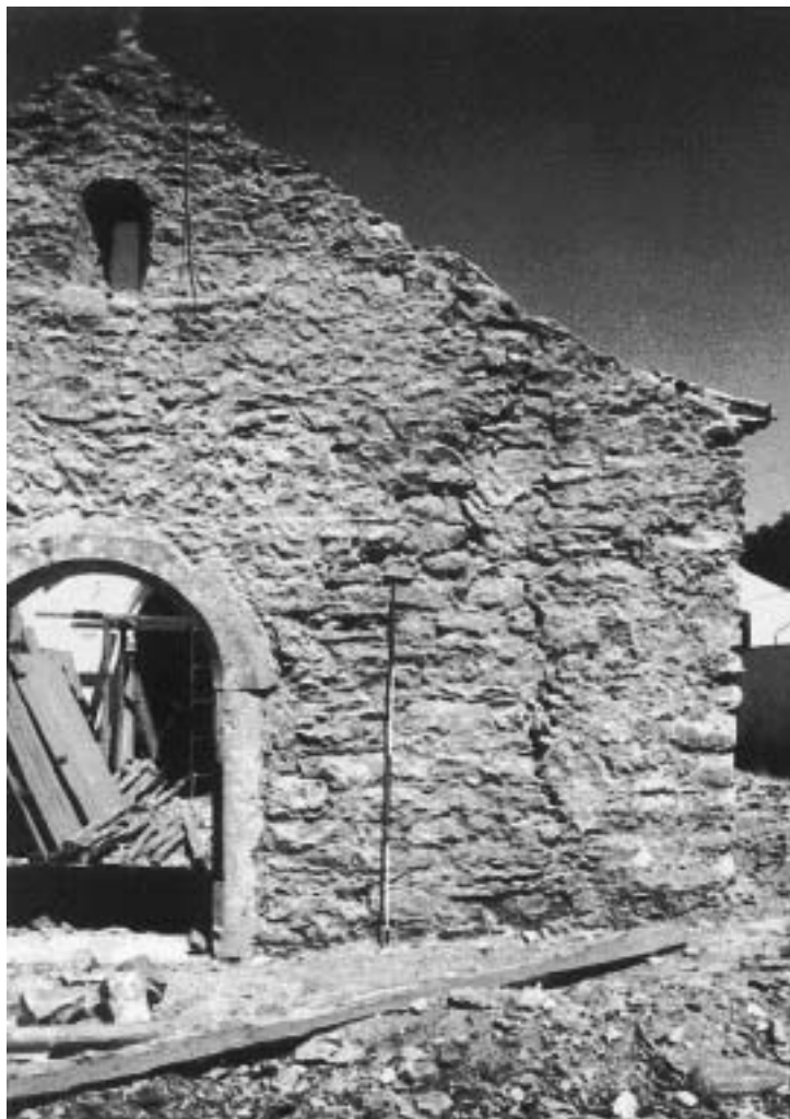
Fig. 12 Ermida do Espírito Santo: fachada principal durante o processo de restauro efectuado em 1988.
