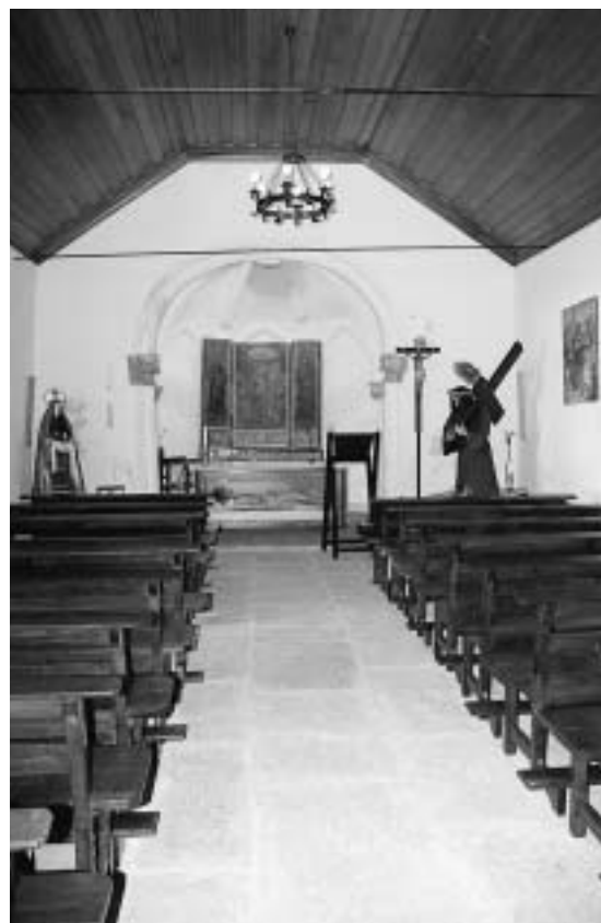
Fig. 19 Ermida do Espírito Santo: perspectiva geral do interior do imóvel após a conclusão dos trabalhos.
