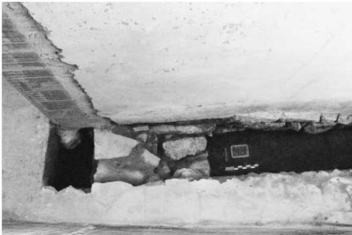
Fig. 7 Ermida do Espírito Santo: perspectiva do alicerce do contraforte diagnosticado da parede norte da nave, na transição para a capela-mor.
