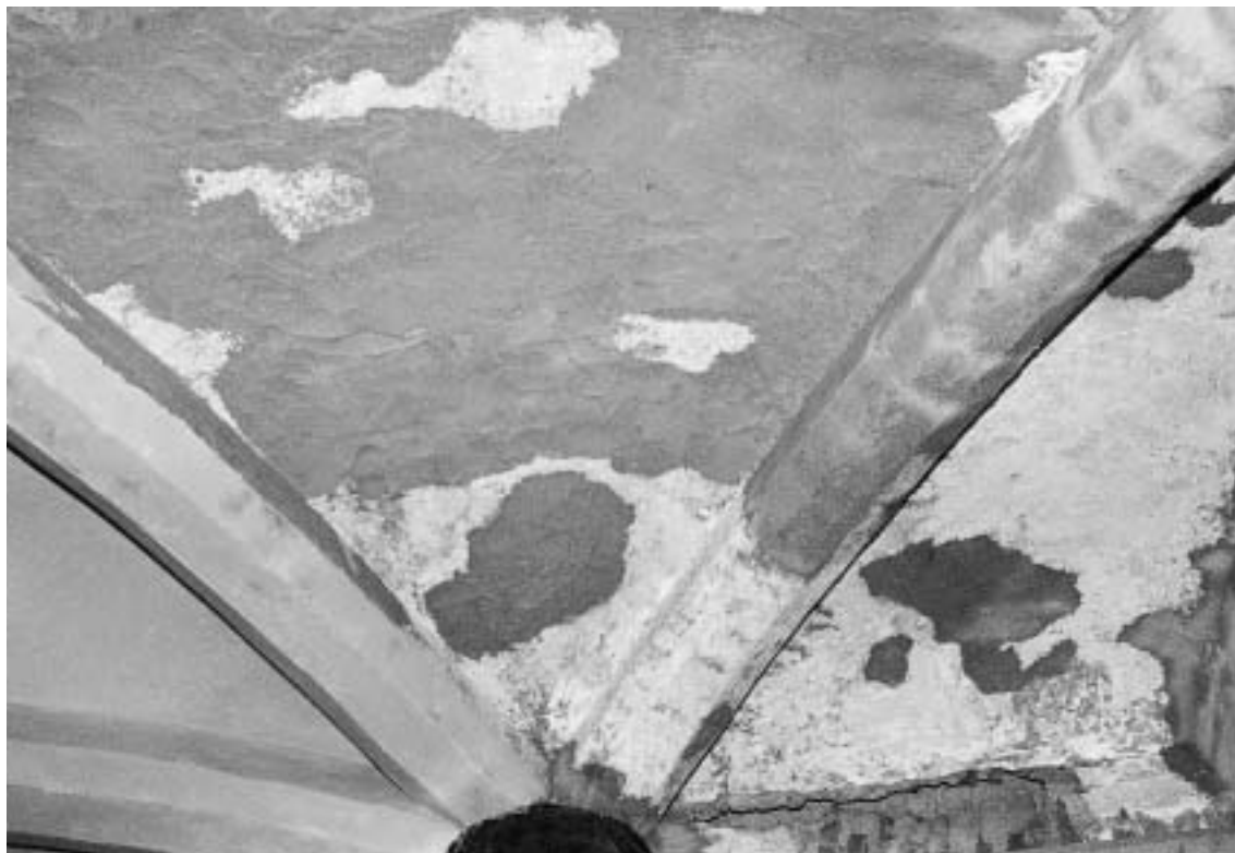
Fig. 16 Ermida do Espírito Santo: preenchimento de lacunas e reboco no tecto da capela-mor.
