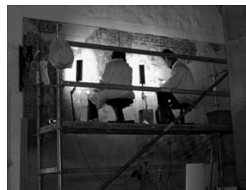
Equipa em intervenção nos painéis da parede sul.
