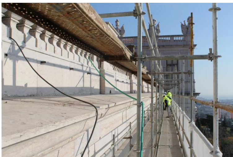
1 e 2 - Limpeza, conservação e restauro de elementos pétreos e pormenor
