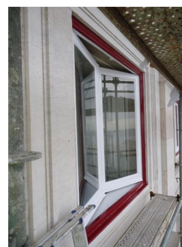
1 e 2 - Limpeza, conservação e restauro de elementos pétreos e pormenor
