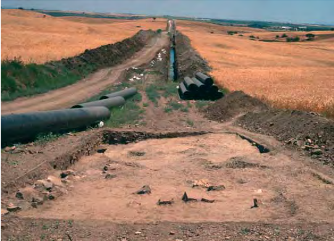
FIG. 6 – Aspecto da escavação na zona 2.
