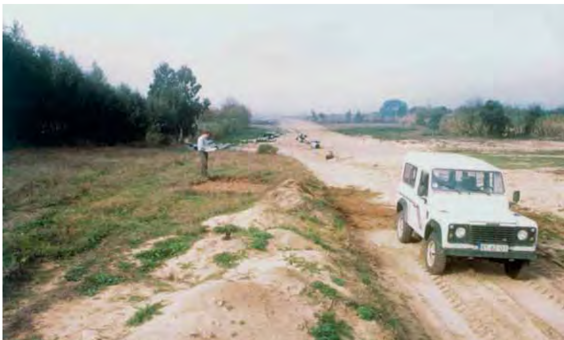
FIG. 9 – Vista geral da sondagem n.º 3 em relação à pista do gasoduto, durante os trabalhos de escavação.
