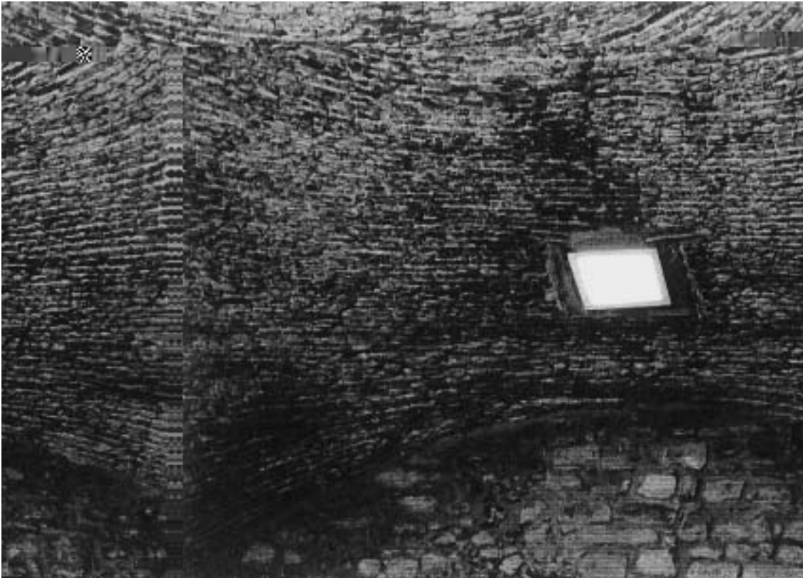
FIG. 9 – Mata-cão, aberto na abóbada que cobre o átrio da entrada principal do Castelo de Silves (R III/99-37).
