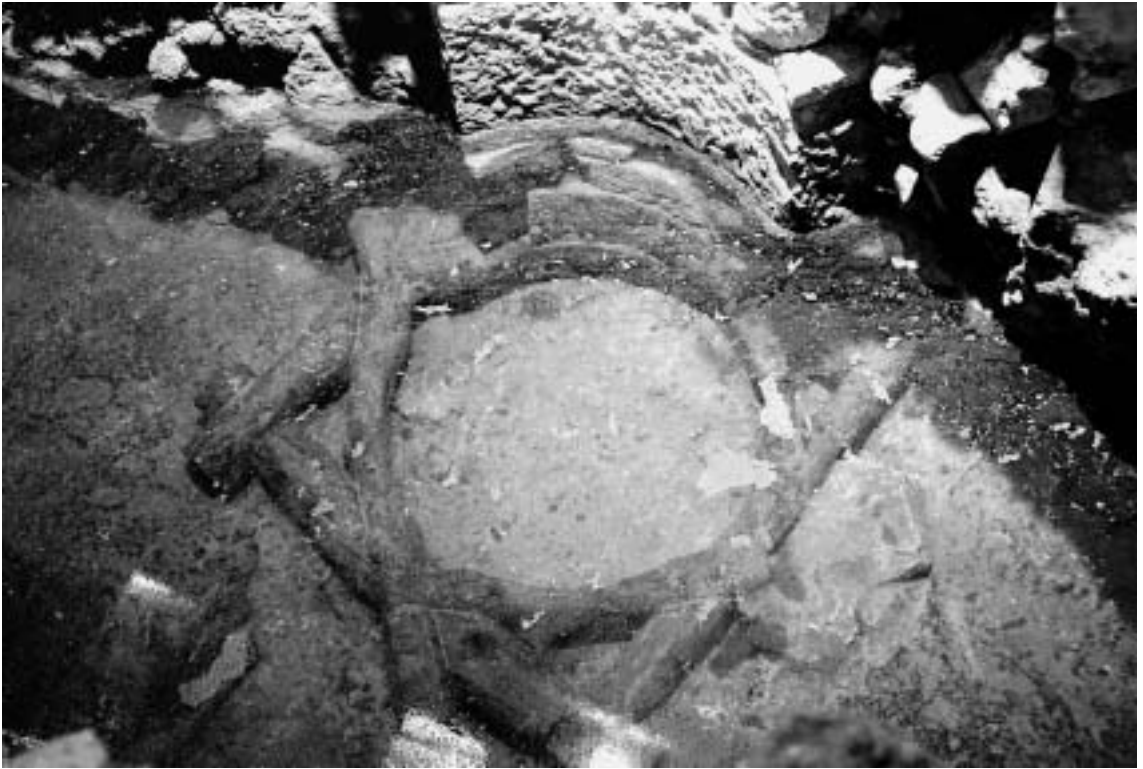
FIG. 4 – Estrutura em madeira de poço pombalino.
