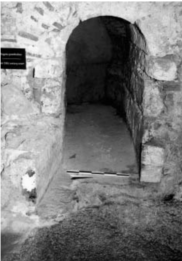
FIG. 5 – Esgoto pombalino.
