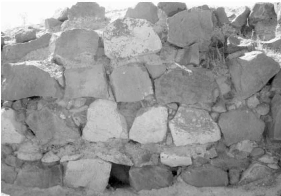
Fig. 5 Torre da muralha de Tall Abu Fahd.
