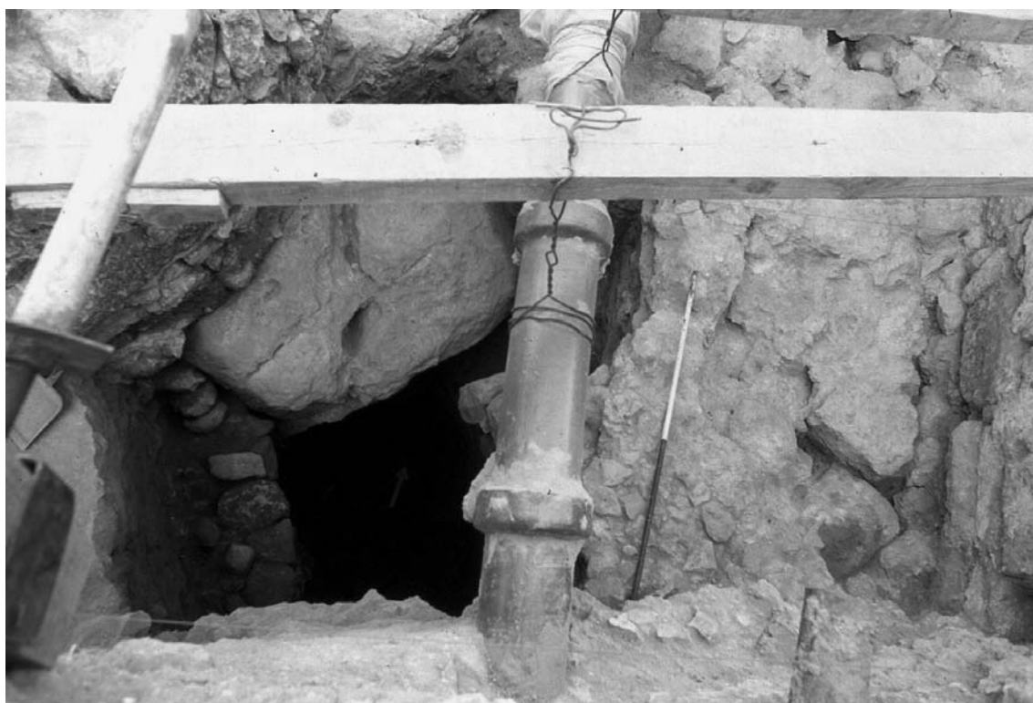
Fig. 8 Pormenor da escavação da Sondagem n.º 2.
