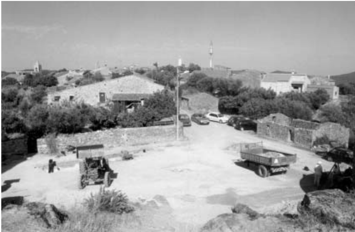
Fig. 7 Aspecto dos trabalhos no Largo do Castelo.
