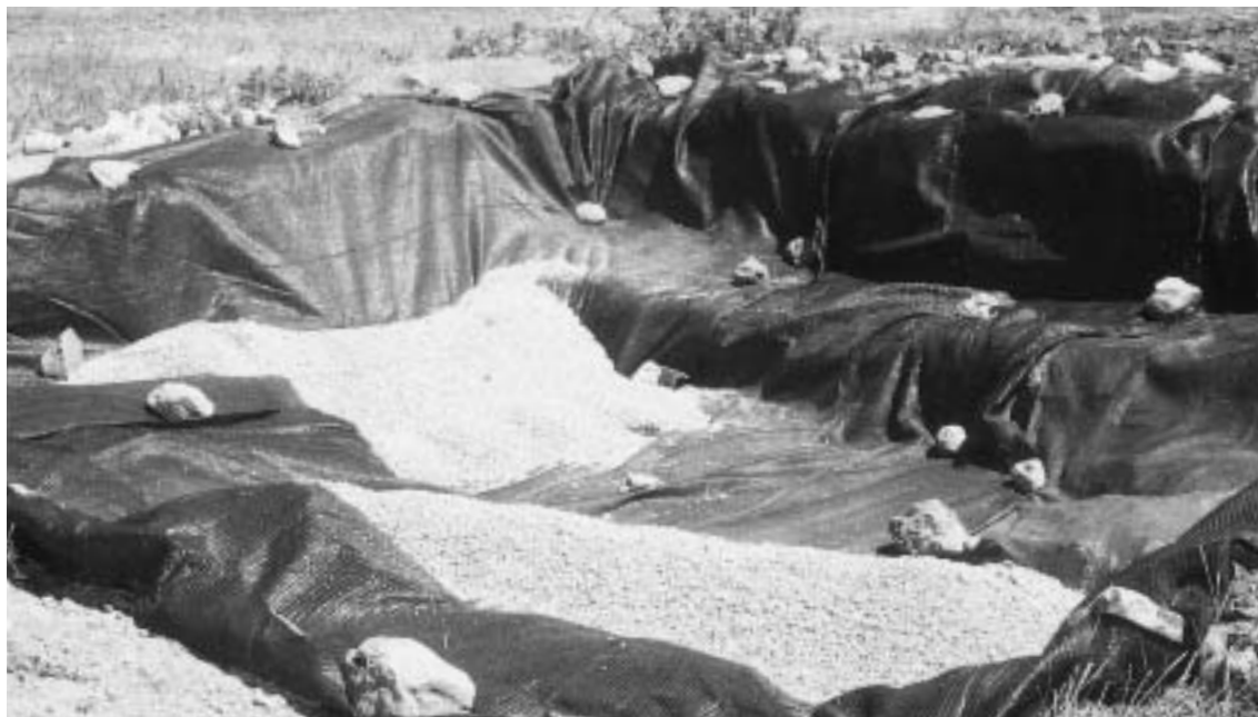
Foto 9 Processo de selagem da pedra romana de Colaride para salvaguarda e protecção do monumento arqueológico.
